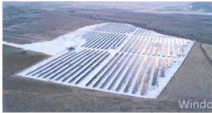
Anadolu Mikronize Niğde-Altunhisar Güneş Enerji Santrali
